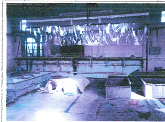
电镀槽、集气罩 1#
