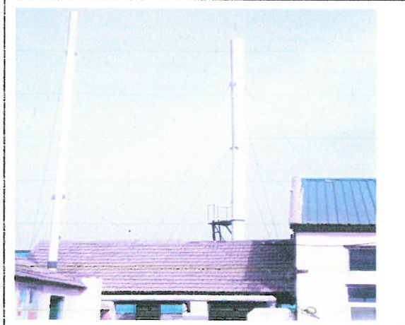
15m 高排气筒
